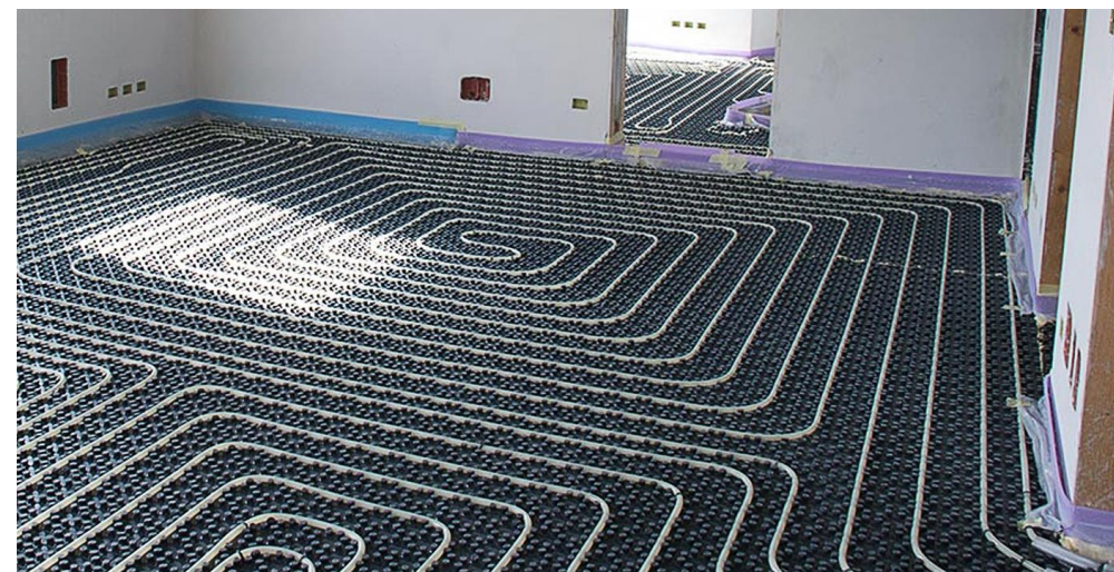
Radiante Raffrescamento / Riscaldamento Acqua a 18°C / 35°C
