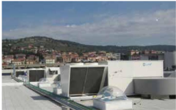
La filtrazione elettronica è impiegata in sistemi rooftop per la climatizzazione di centri commerciali e cinema multisala. È particolarmente efficace per la purificazione dell'aria in zone densamente urbanizzate.
